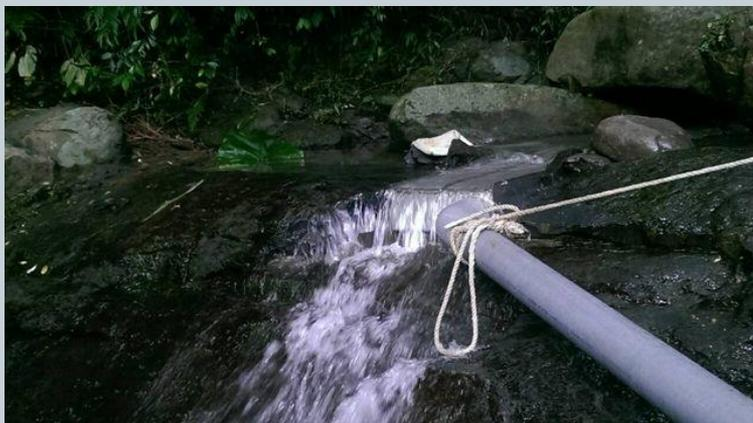
1. 安裝於三峽山區溪流上游利用PVC管引水到下方約15公尺進行發電測試
